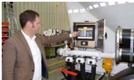
Digitale Zukunft: das Silo-4.0-System „FFB Smart Silo Control“ ...
